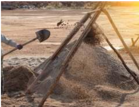
Gambar 5.26 Metode pengayakan yang dilakukan oleh pekerja bangunan.
